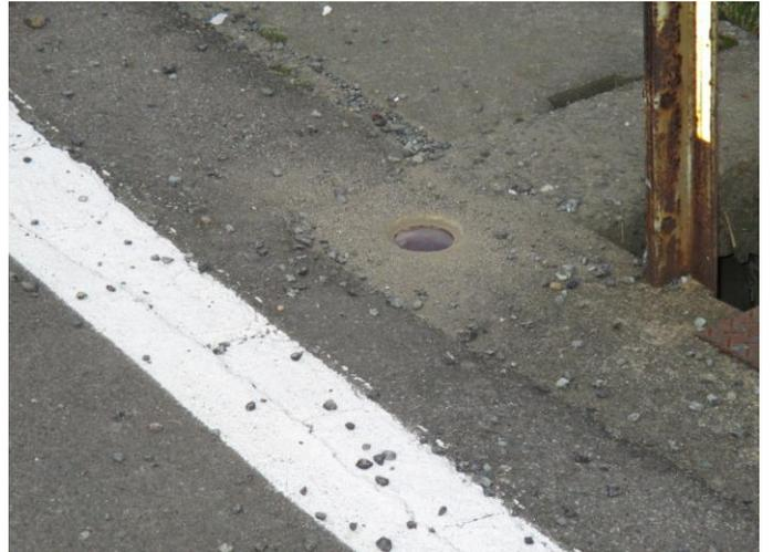
**【図根多角点、細部図根点】**
